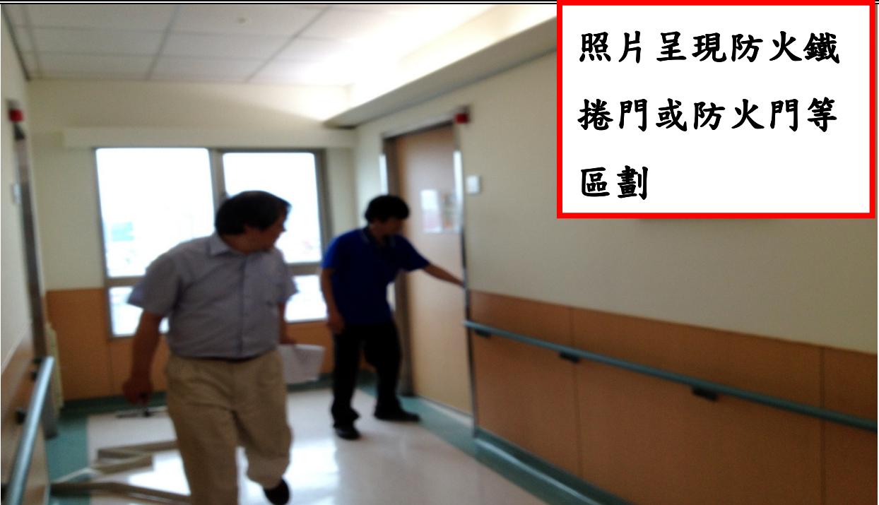
說明：防火鐵捲門、防火門區劃確認
